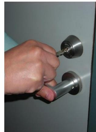
玄関の鍵が、ちょっと硬くなったと感じたとき、スプレー式の合成潤滑油を注している方はいませんか？合成潤滑油は最初は滑りも良くなりますが、油分がホコリを付着させて時間の経過にともない逆に硬くなってしまいます。鍵専用の潤滑剤は、油分の含まれていないパウダースプレーがホームセンター等で売っています。後で鍵そのものを交換しなければならなくなったという事が無いように鍵専用のものを使うようにしましょう。
