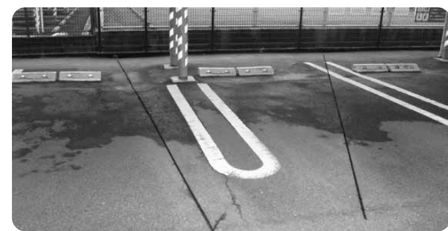
駐車場に水を流す溝を設けました。
