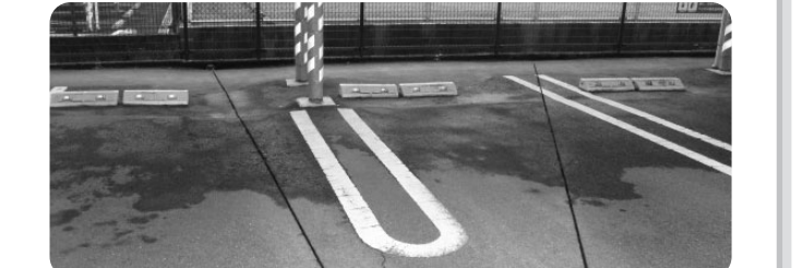
駐車場に水を流す溝を設けました。
