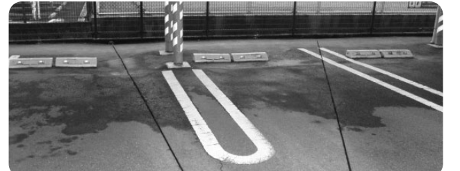
駐車場に水を流す溝を設けました。
