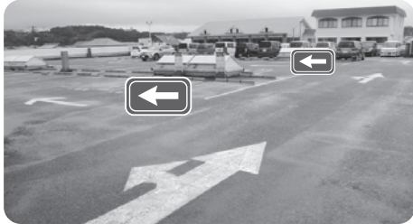
2階駐車場の登り口から見たところ
